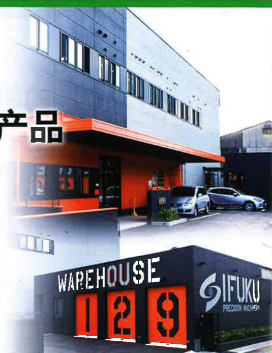
2017年8月竣工的新总部工厂
